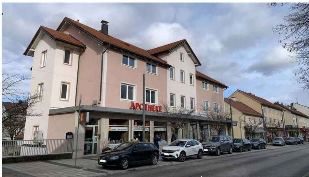
Streitobjekt: Die Menagehaus-Zeile an der Bahnhofstraße bis zur Friedrich-Ebert-Straße und deren Zukunft beschäftigt Lokalpolitik und Denkmalverein in Penzberg. © Andreas Baar
